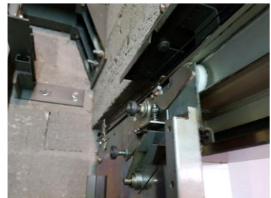
Serrure de porte palière du niveau principal
